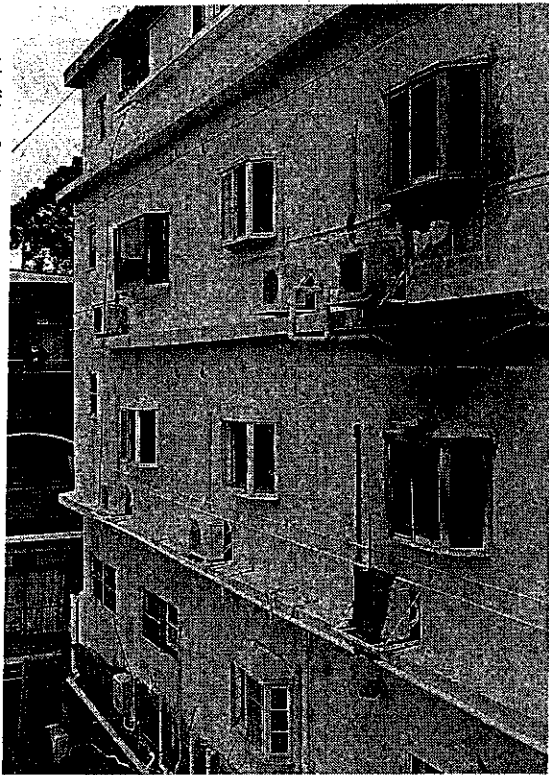
火災があったグループホーム「ベルハウス東山手」（9日午前、長崎市）
